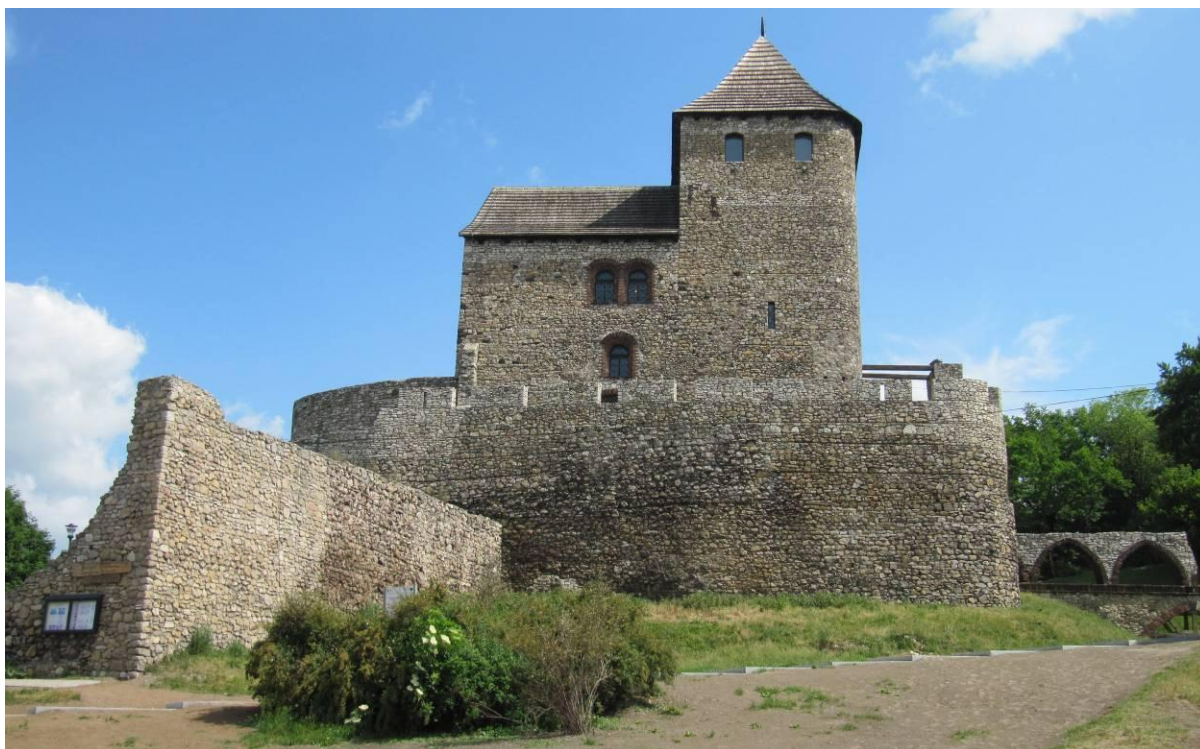
Rys. 3. Widok zamku od strony południowej
