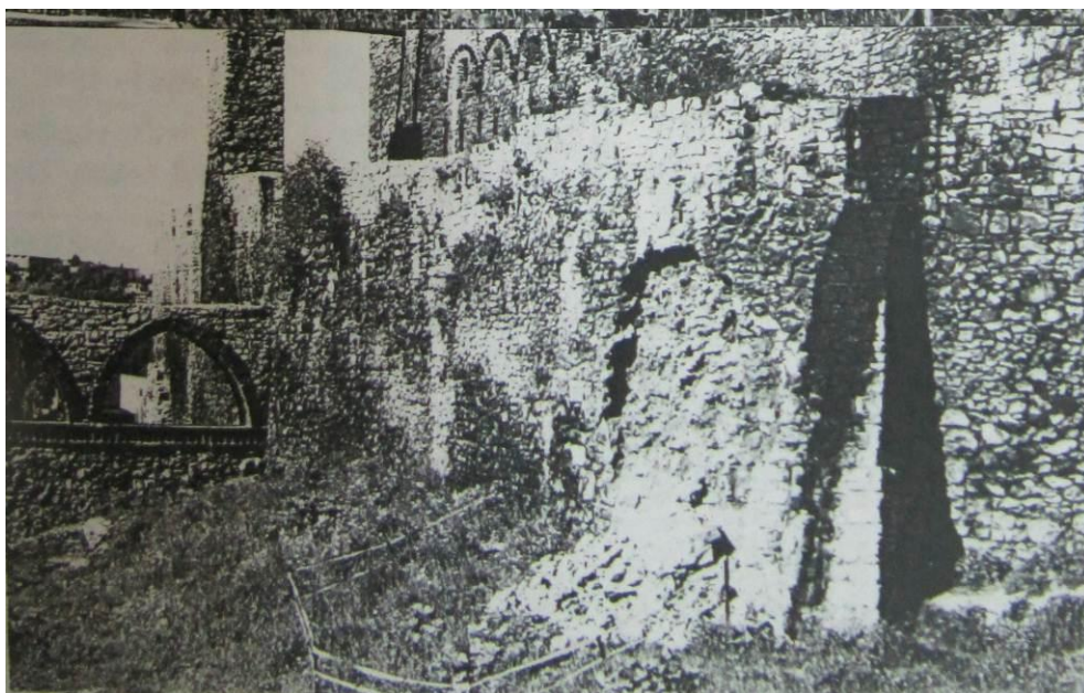
Rys. 20. Odpadnięcie lica muru wschodniego Zamku Będzińskiego w dniu 30. 04. 2001 r. [2.8]
