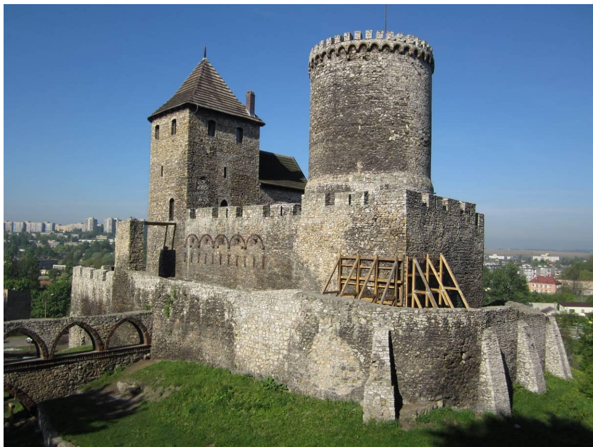
Rys. 1. Widok zamku od strony północno-wschodniej
