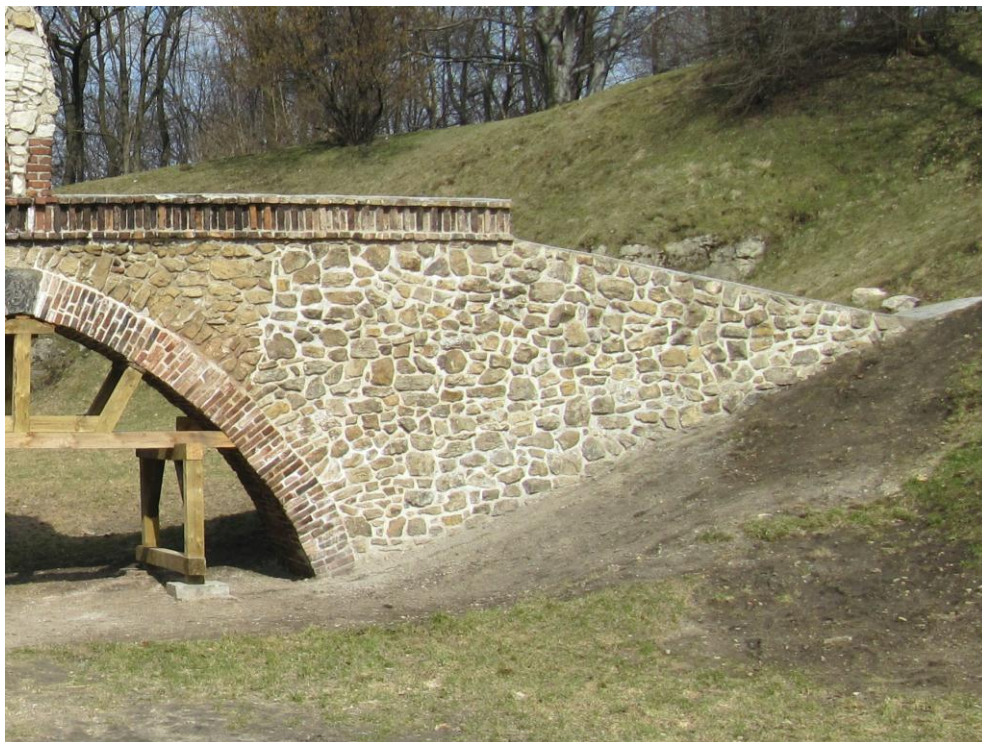
Rys. 24. Odbudowany fragment muru arkadowego zamku w Będzinie po uszkodzeniach z 2010 r.
